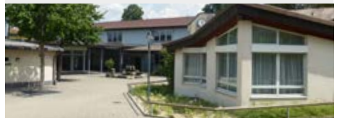
Sanierungsbedarf beim HVV Schulzentrum Eichstetten
