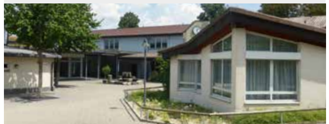
Sanierungsbedarf beim HVV Schulzentrum Eichstetten
